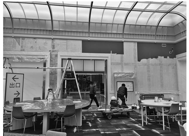
壁紙の張り替え作業の様子
