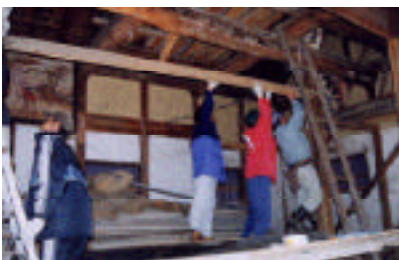
図4 本手の背後に絵襖を入れるための鴨居を取り付ける。
