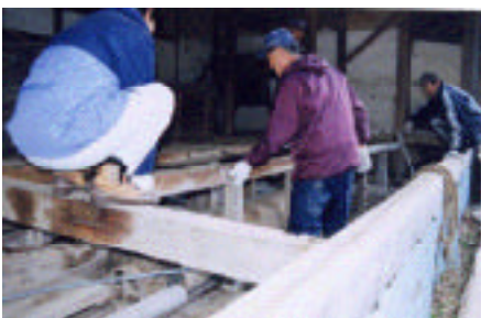
図1 人形を操る場、上段(本手)、下段(二の手)を設けるため平面の床板をとりはずす。
