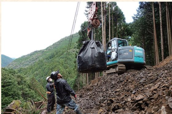
図2 索道を使った岩石の運搬作業 (2021年10月26日撮影)
