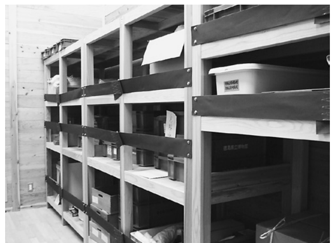
歴史民俗蔵庫での耐震ベルトの設置
