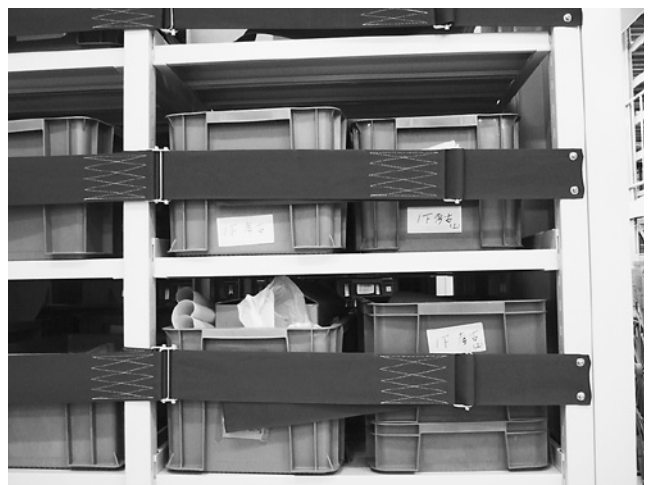
耐震ベルトの設置状況
