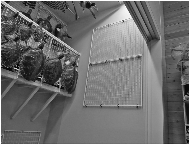
ワイヤーメッシュの取付（生物収蔵庫内）
