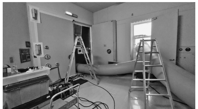
収蔵庫全室密閉燻蒸の排気
