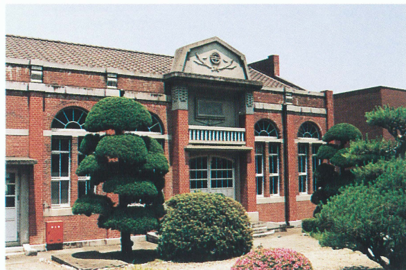
図1 1924年の調査後に建てられた佐古浄水場
