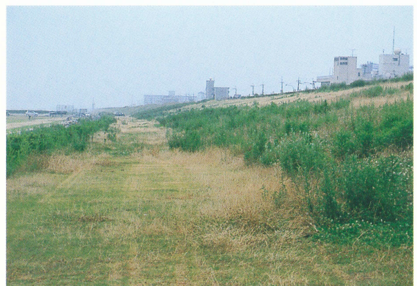
図3 ビラが発見された吉野川下流右岸の堤防下。画面右上の白い建物(老人福祉施設「白寿会」)の堤防下付近。
