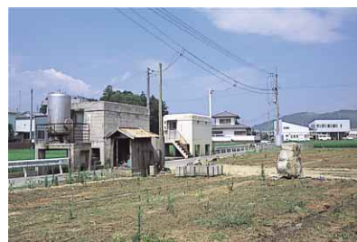
図3：規模の大きな揚水ポンプ場（大木地区）。 大木団地、東山団地などで使う水道の水源地となっている。
