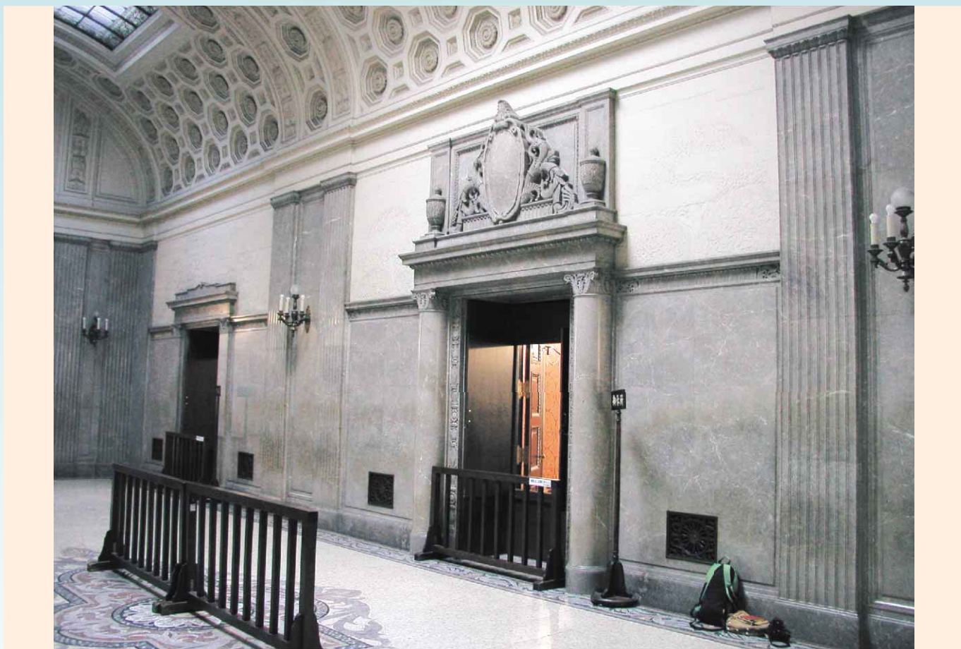
国会議事堂の内装に使われている徳島県産石灰岩
