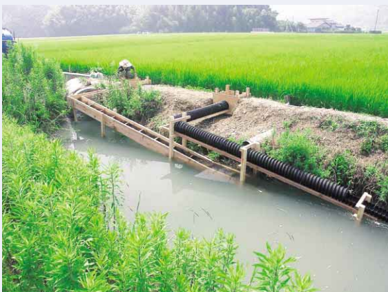
図1 水田魚道の設置の様子(小松島市立江榑洲土地改良区)
