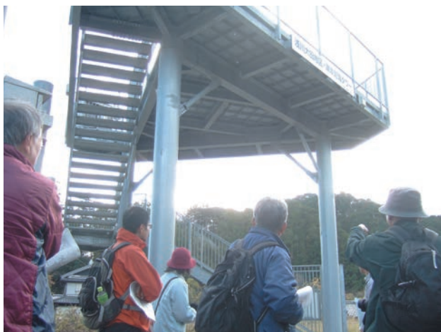
津波避難タワー
