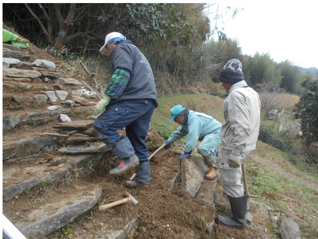
山崎忌部神社の階段修復作業
