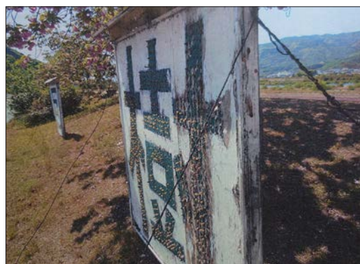
図2 劣化した看板
