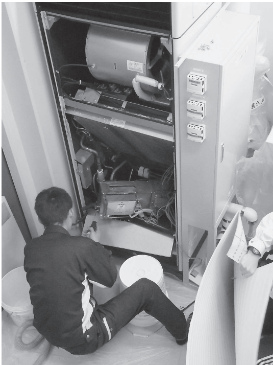
エアコン内部洗浄の様子
